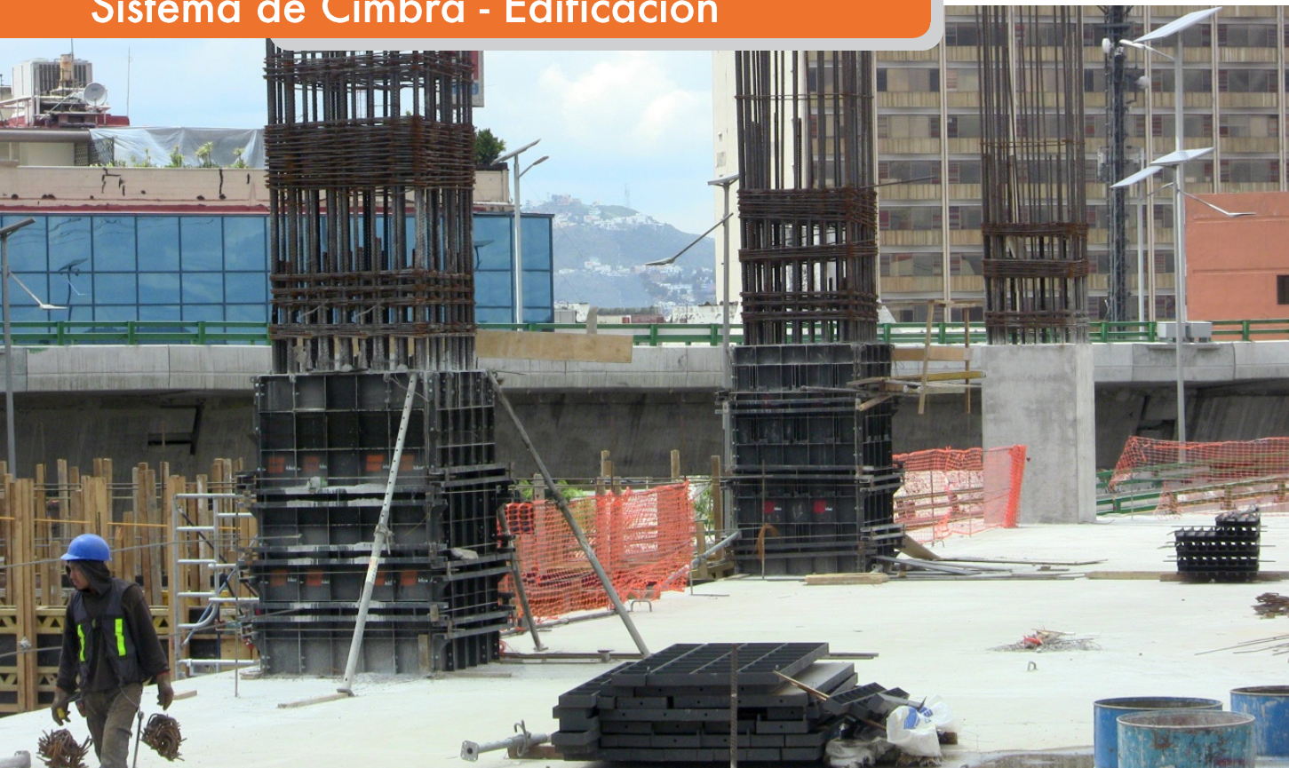
• Centro comercial en la Ciudad de México • Utilización de cimbra metálica para columnas
